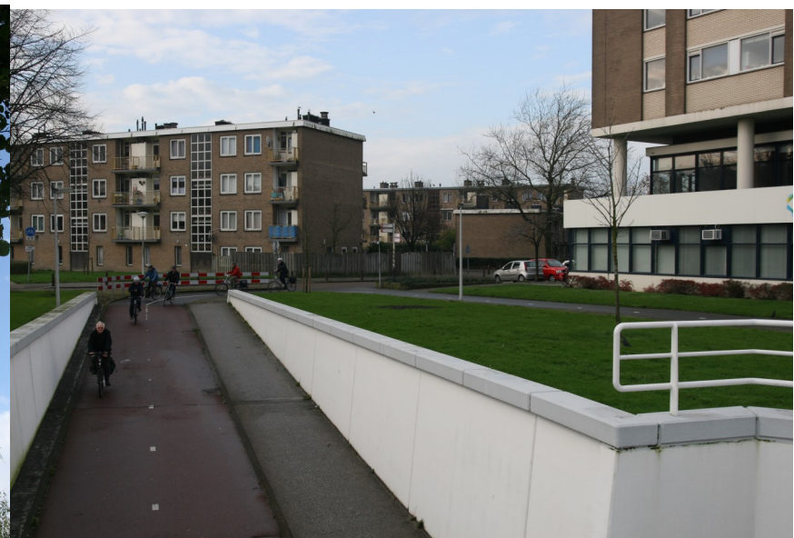
Fietstunnel Persant Snoepweg
